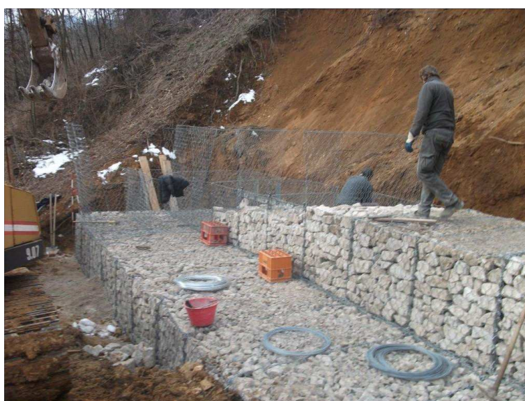
Foto 6. Realizzazione di una struttura di sostegno in gabbioni metallici.
