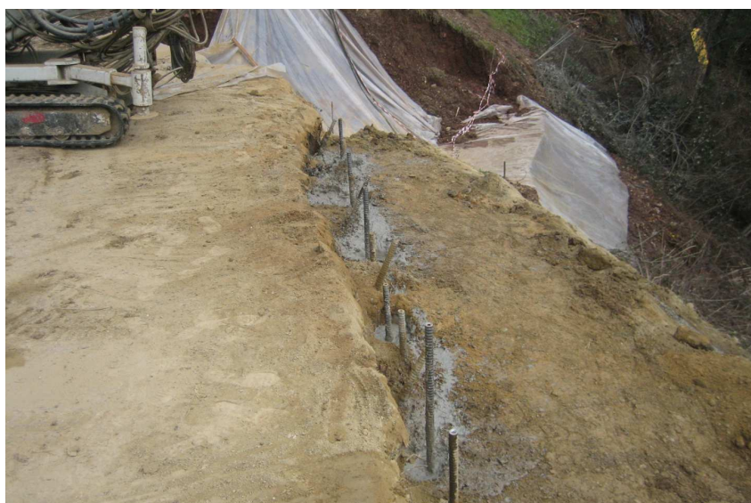
Foto 5. Esempio di fondazione eseguita con barre autoperforanti verticali ed inclinate.
