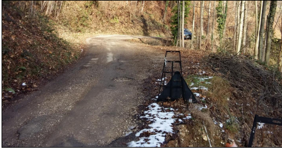
Foto 1 - Tratto 1 - panoramica da sud del tratto di strada oggetto dell'intervento
