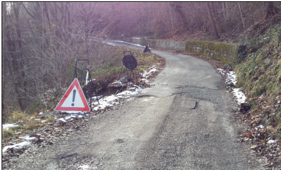
Foto n. 2 - Tratto 2 - panoramica da nord del tratto di strada oggetto dell'intervento
