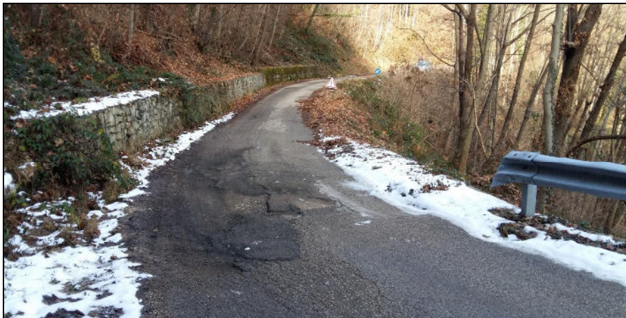
Foto n. 3 - Tratto 3 - vista da sud del tratto di strada oggetto dell'intervento
