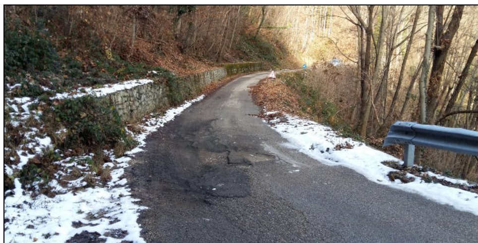
panoramica da sud del tratto di strada oggetto dell'intervento
