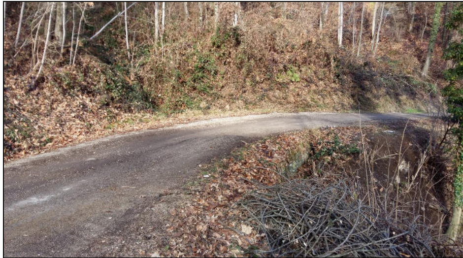
vista del tratto di strada oggetto dell'intervento nel punto in cui attraversa la valletta
