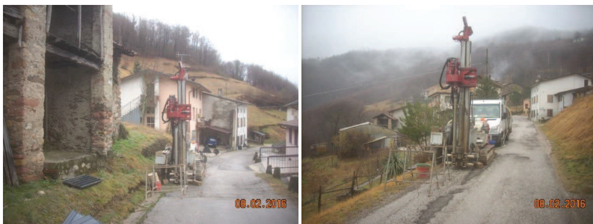
Figura 4 - Sonda Comacchio Geo 305 posizionata rispettivamente sul Sondaggio Geognostico S1 e S2
