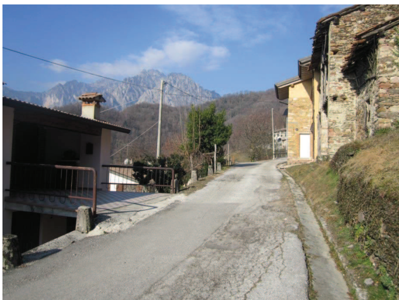
Figura 27 – Tratto di strada interessato dal consolidamento
