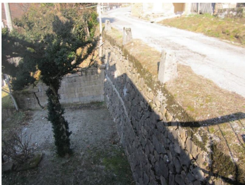
Figura 28 - Muro a secco interessato dal consolidamento
